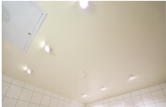
Taket i fiberarmert betong har ingen kassettskjøter.
